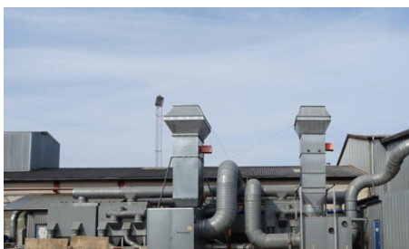
Hal 8 og 9 Afkast hal til overfladebehandling og blæsehal (tv.)
