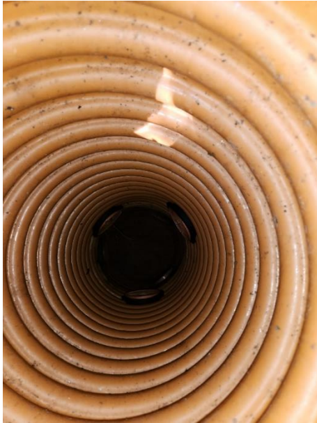
Foto 6: Perkolatbrønd. Af billedet fremgår, at der er et vandspejl i bunden af brønden.
