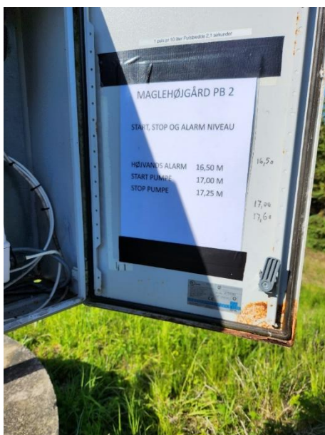
Foto 2: Nye niveauer for pumpestop i perkolatpumpebrønd PB2 (sydlige pumpebrønd).
