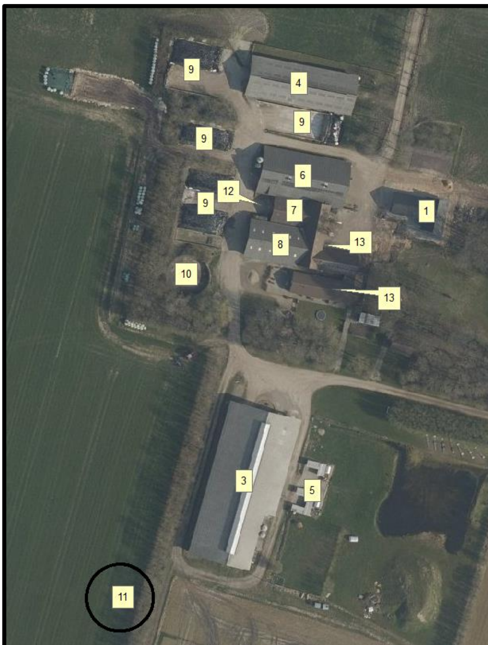
Figur 3. Oversigt over husdyrbrugets bygninger.
