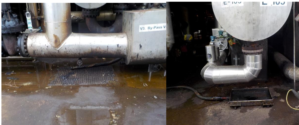
Figur 3. Tømning af spildbakke gennem slange til kloak.
