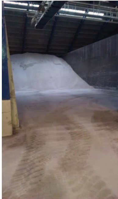
Figur 4: Celle i bulklager med gødning.
