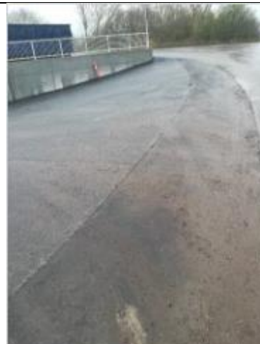
Forhøjning i vejen der forhindrer overfladevand i at løbe ned mod graven ved omlasteplads for madaffald
