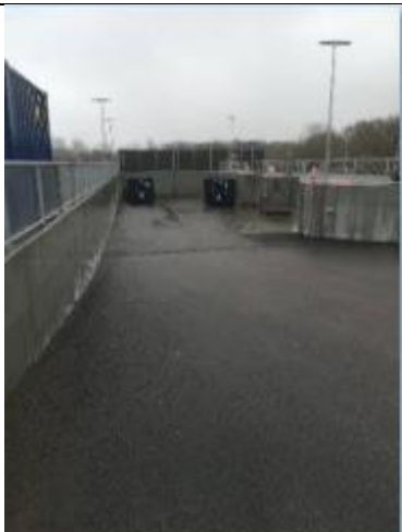
Foto ned i graven på omlastepladsen
