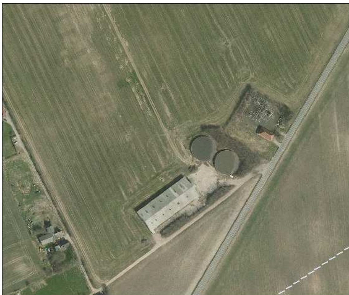
Luftfoto og oversigt over ejendommen Bråskovvej 2b, Hornsyld
