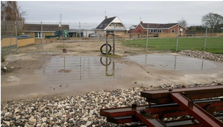
Billede nr. 3: Areal ved den tidligere påfyldningsplads. Kanten med stenene fungerer som nedsivning og forsinkelse.
