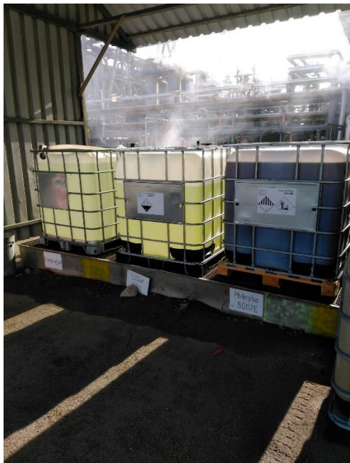
Opbevaring af kemikalier blok 1, Tre pallettanke på spildbakke
