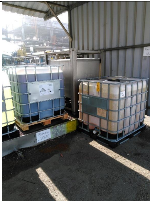
Opbevaring af kemikalier blok 1, En pallettanke udenfor spildbakke
