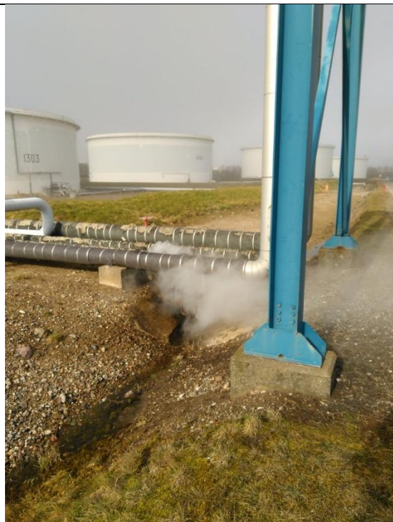
Eksempel på damplækage
