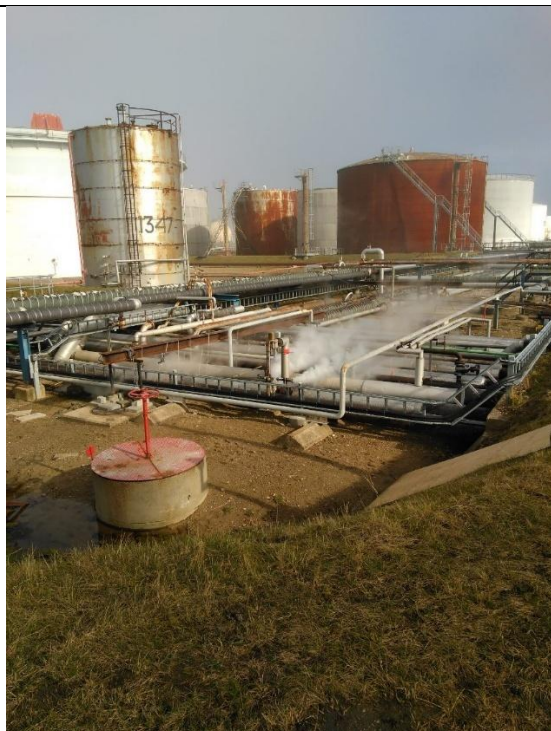
Eksempel på damplækage
