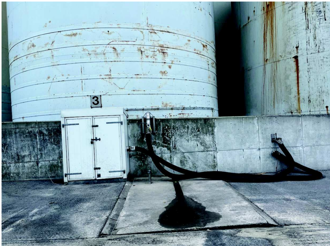
Tankpladsen, hvor lastbiler kobles til. Set fra Østhavnsvej.
