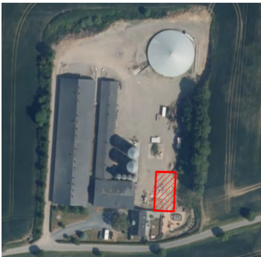
Figur 1. Maskinhusets placering (rød markering).
