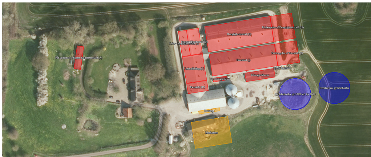
Figur 1: Husdyrbrugets stalde, opbevaringsanlæg mv. (dog uden gyllebeholder på Hjortspringvej 24)
