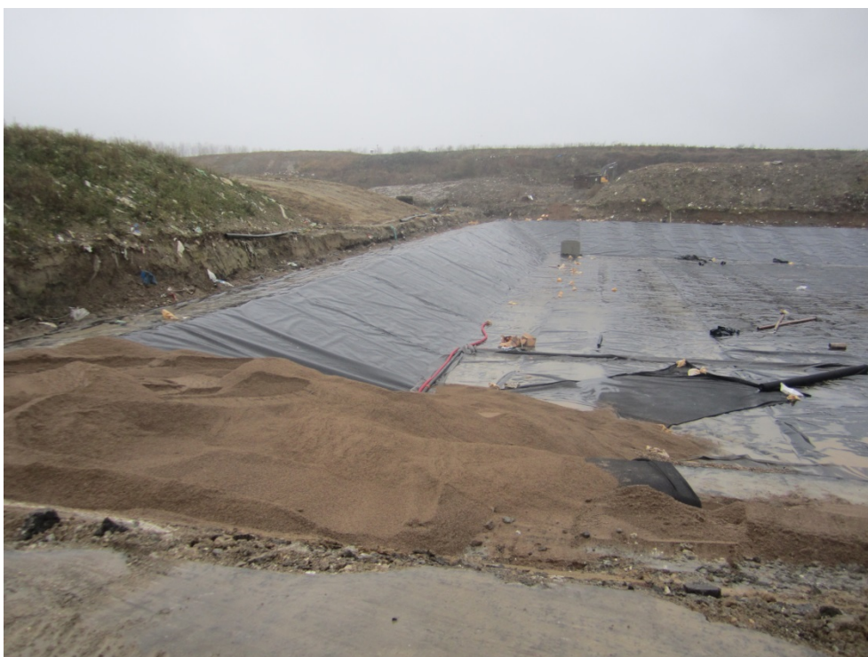
Foto 10 Påbegyndt udlægning af dræn og beskyttelsesgrus i det sydøstlige hjørne
