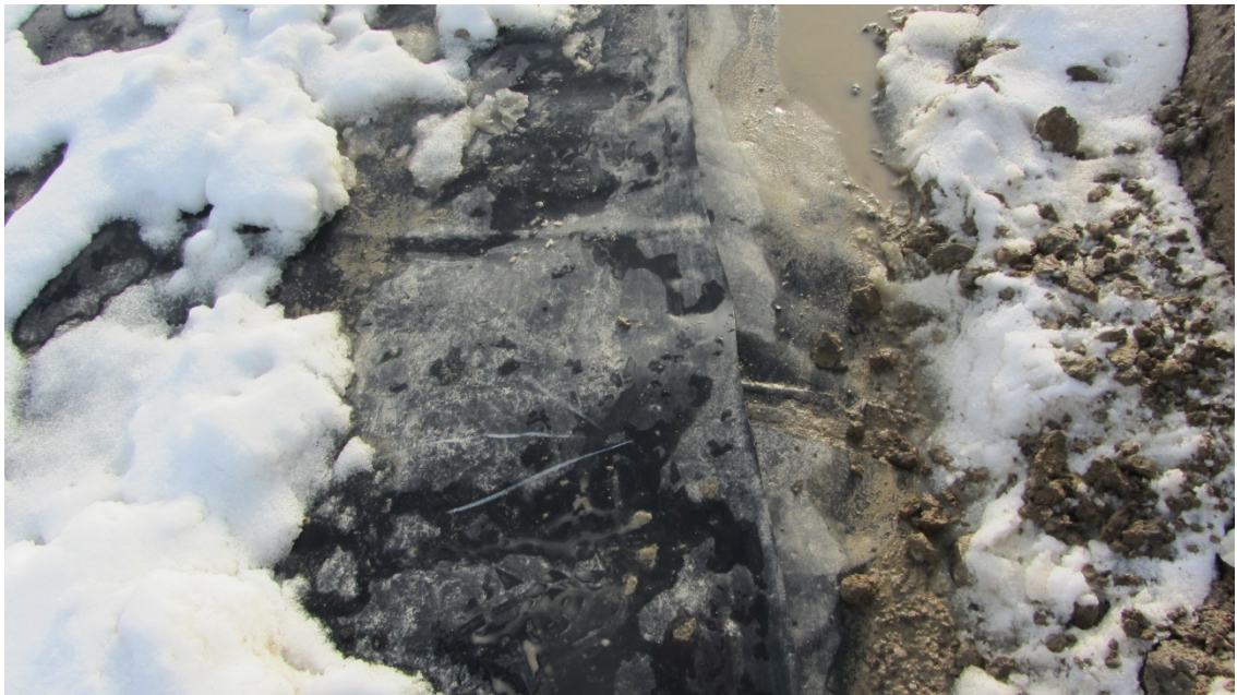
Foto 4 Markering på polymermembran, hvor der skal udføres reparation. (På den vestlige vold)
