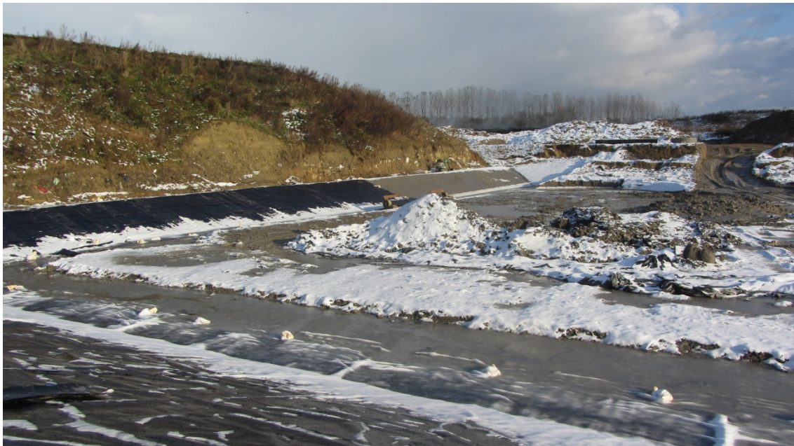
Foto 8 Udlagt polymermembran på den vestlige og nordlige vold. Set fra vest mod nordøst.
