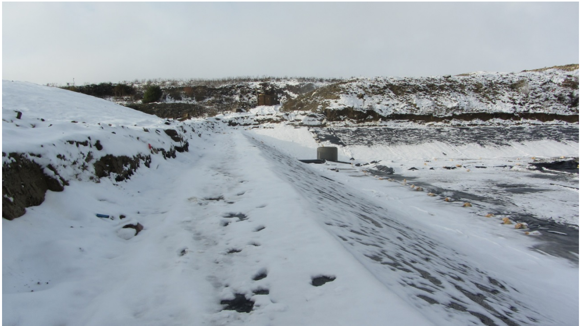
Foto 3 Den sydlige skråning med udlagt polymermembran (dækket af sne). Set fra øst mod vest
