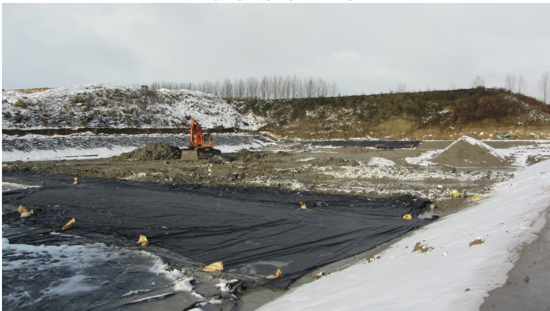
Foto 1 Lermembran dækket med landbrugsplast. Der pumpes vand fra foden af volden. Set fra sydøst
