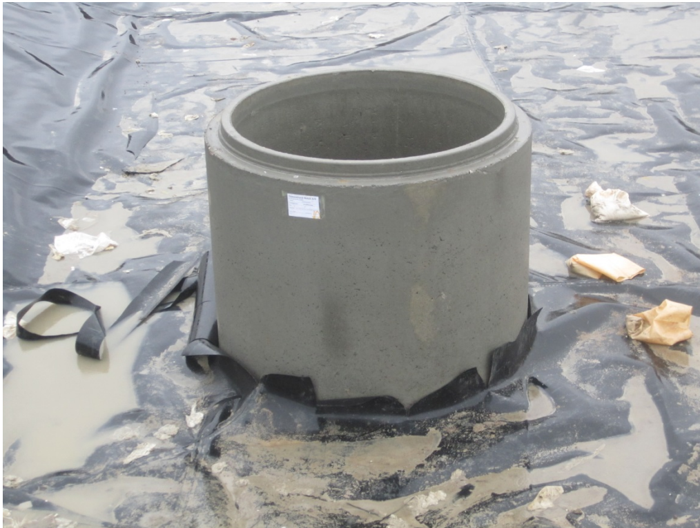
Foto 11 Perkolatbrønd i det sydvestlige hjørne, hvor polymermembranen endnu ikke er monteret tæt til brønden.
