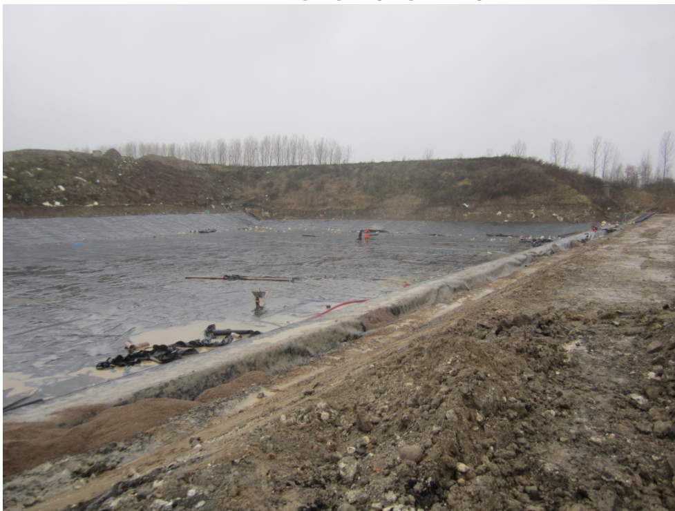
Foto 9 Udlagt polymermembran i hele deponiet. Set fra sydøst mod nordvest
