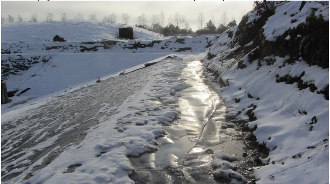
Foto 6 Sammensvejsning mellem ny og gammel polymermembran på vestlige vold. Set mod syd
