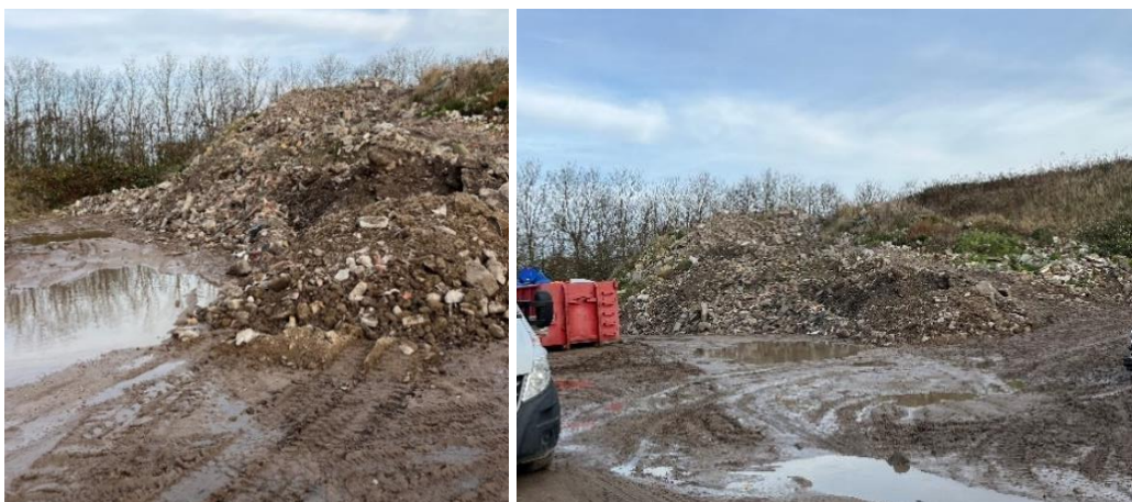
Oplag af bygge- og anlægsaffald er placeret ovenpå del af deponiet.
