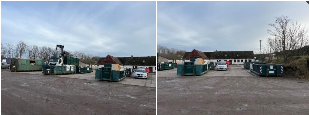
Belægning på genbrugspladsen er delvis med SF sten
