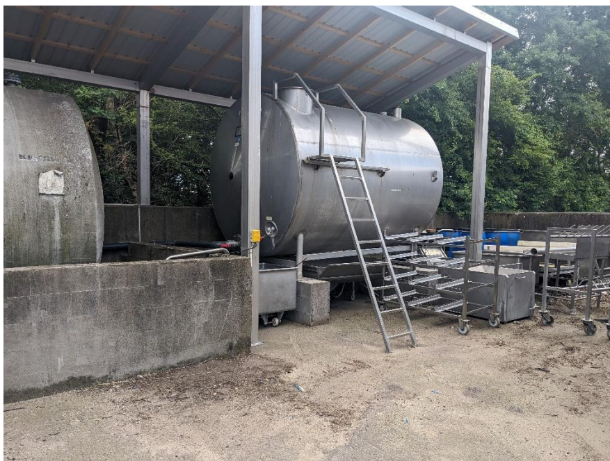
Ludtank uden tankgård opstillet ved siden af udligningstank.
