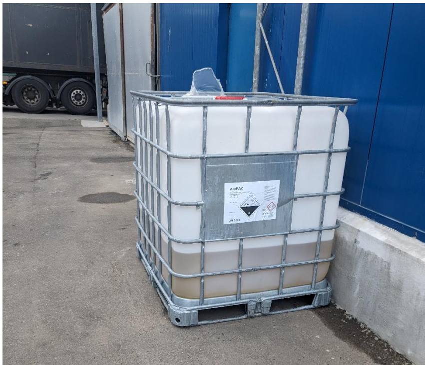
Palletank med kemi opstillet uden mulighed for opsamling
