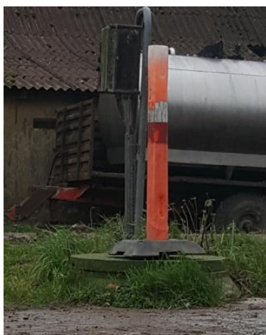
Figur 2 Kegleformet brøndring om boring 142.738
