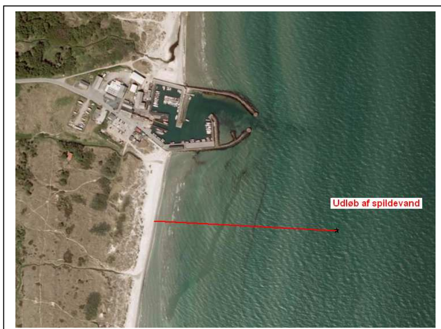
Figur 1 Udløbssted for spildevand
