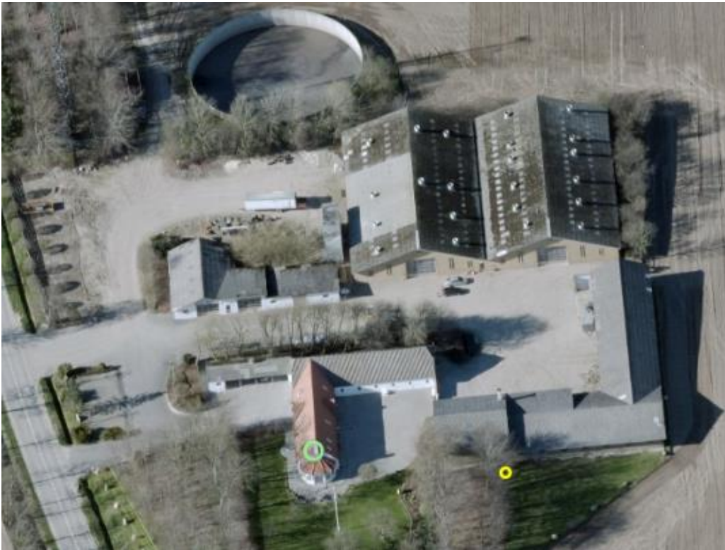
Figur 2: Ejendommen set fra syd
