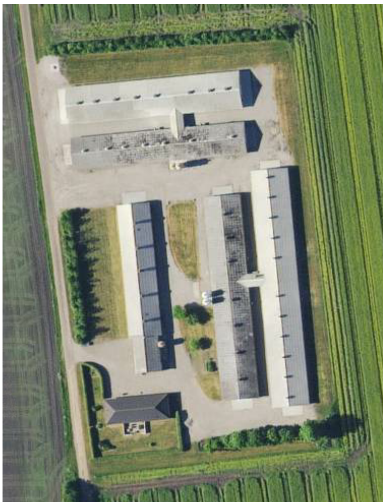
Figur 1. Oversigt over bygninger.
