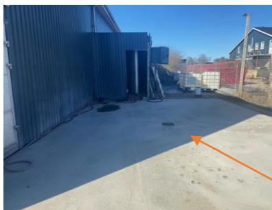
Container med pumpe og Ad Blue
