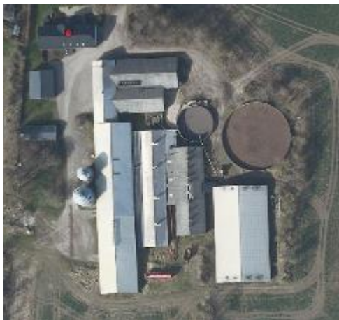
Figur 1. Oversigt over bygninger.
