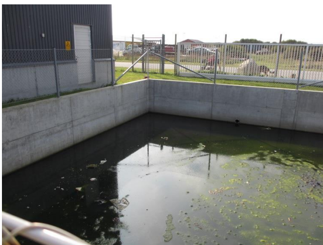
Fig. 8 Forsinkelsesbassin for overfladevand fra genbrugsplads.
