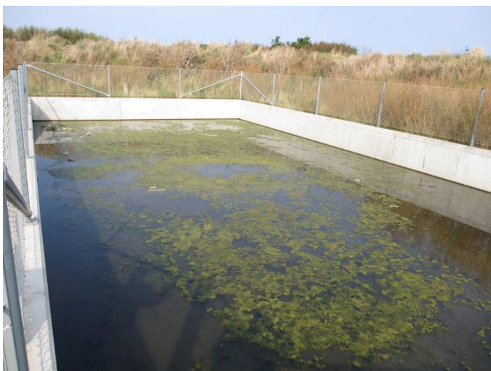
Fig. 6 Forsinkelsesbassinet nord for pladsen for forbrændingsegnet affald.
