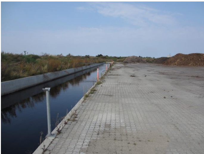
Fig. 5 Komposteringsplads med bassin til opsamling af overfladevand.
