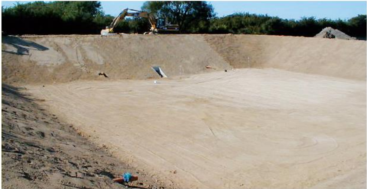
Figur 5 – Eksempel på udgravning til bassin.
