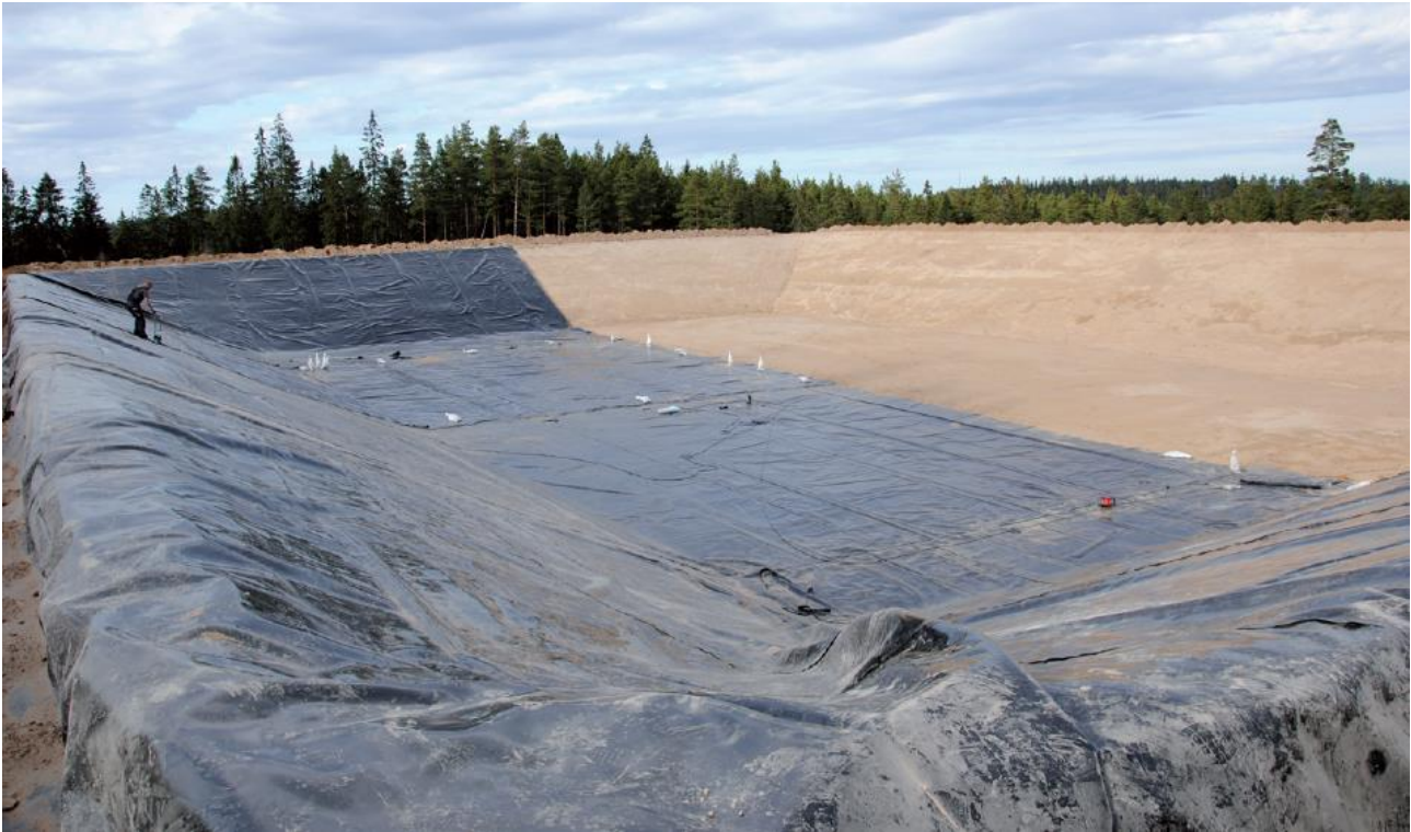
Figur 6 - Eksempel på etablering af membran.
