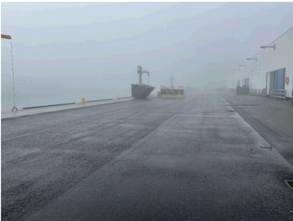
Figur 1. Den nye udvidelse af kajen ses.
