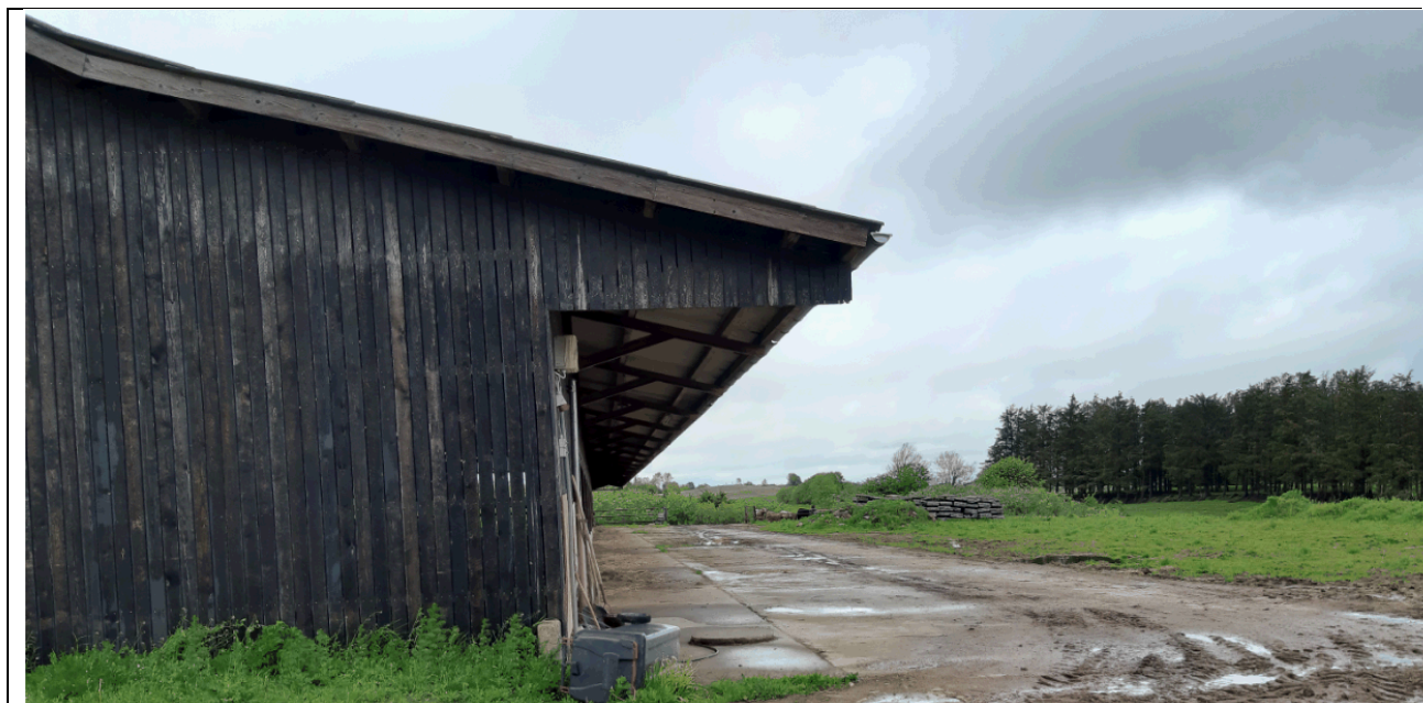
Billede af stalden set fra syd. Foderbordet er overdækket.
