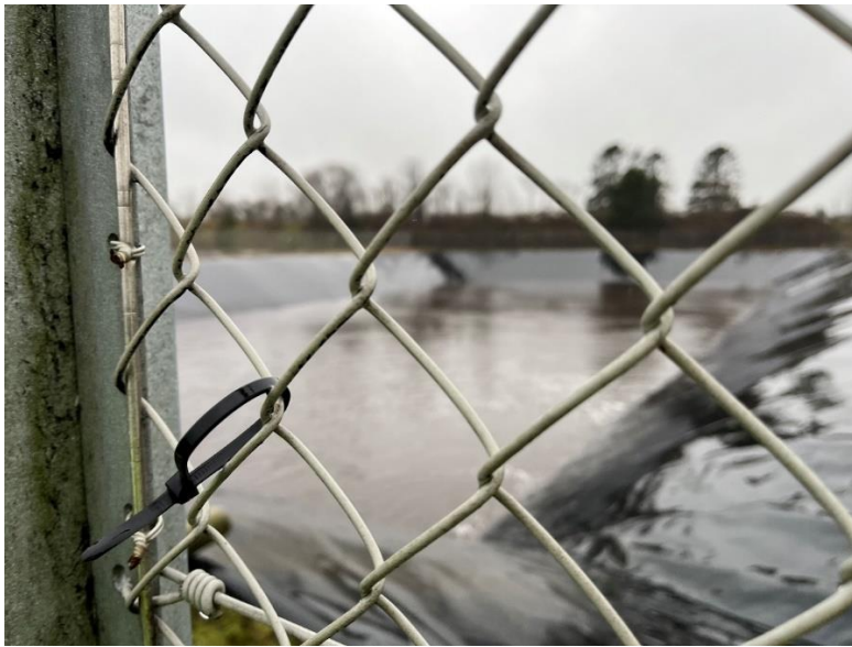
Figur 8: Den ene af 2 laguner til opsamling af overfladevand.
