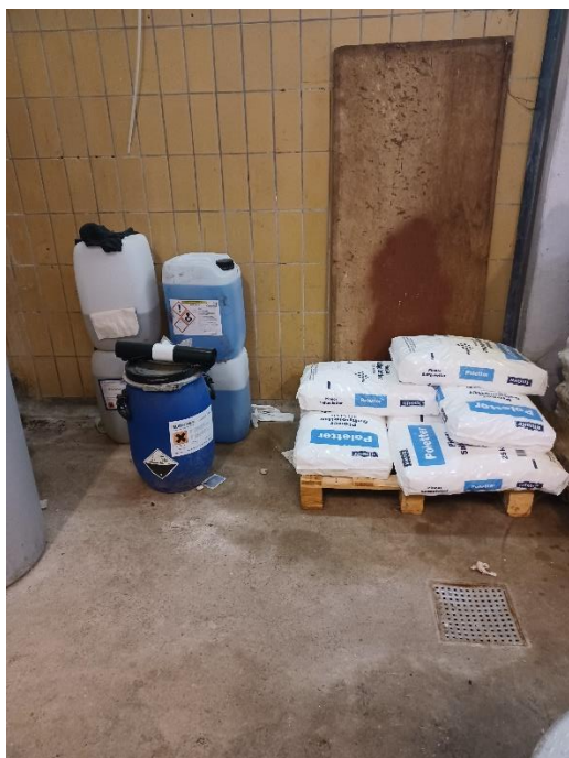
Kompressorrum: Oplag af diverse rengøringsmidler uden opsamlingsbakke.
