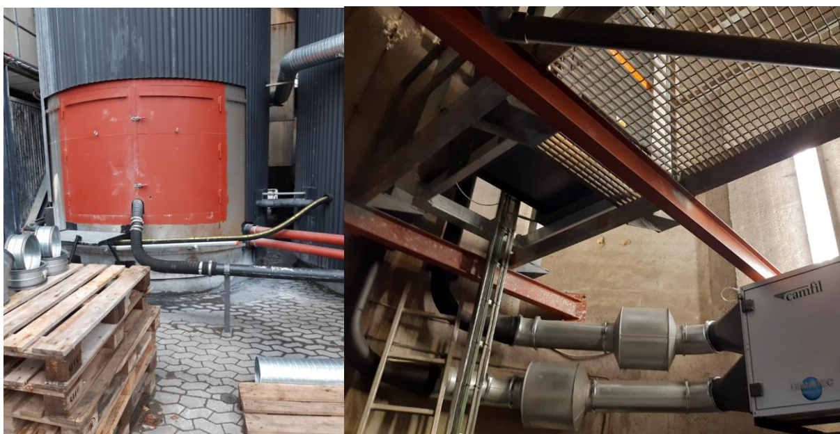
Figur 2 – dele af anlægsforbedringerne – kuldosering og redundant kalkdoseringsanlæg på ovnlinje 2
