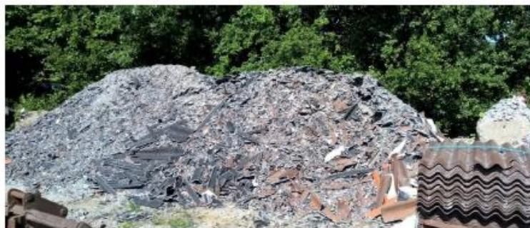
Knuste tagplader: sørg for dokumentation/analyse af, at tagpladerne ikke indeholder asbest! Foto: Aalborg Kommune
