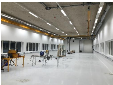
Nye produktionshaller med kraner
