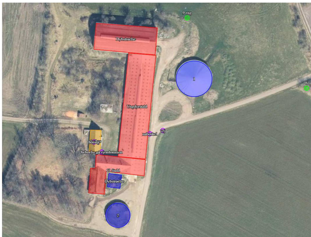
Figur 1: oversigt over staldanlæg mm.
