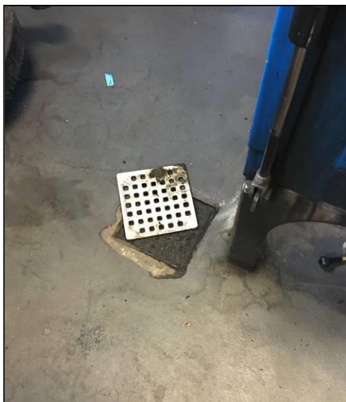
Foto af bremsevasker øverst. Til venstre ses det afblændede gulv afløb.
