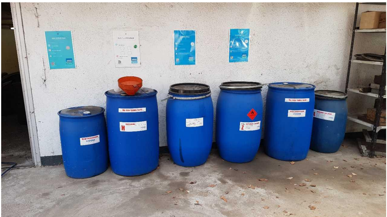
Opbevaring af farligt affald i blå plasttromler fra Stena. Der er ingen spildsikring.
