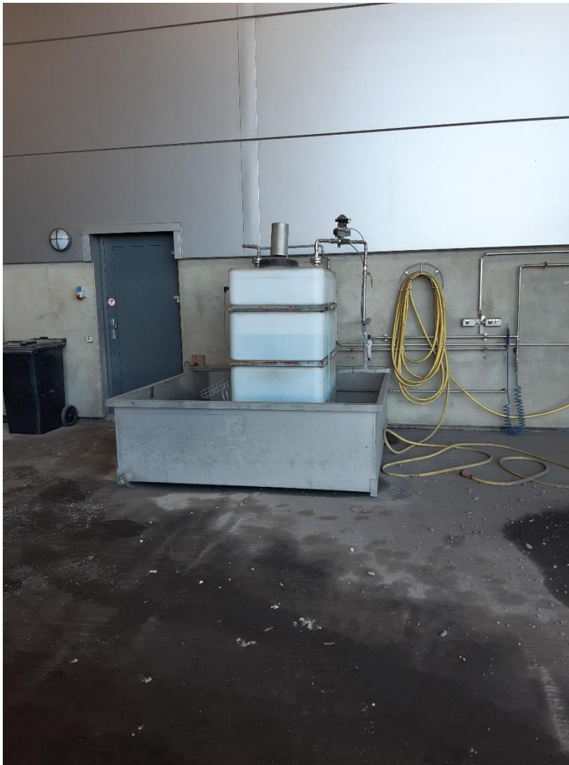
Mellemtank til ammoniakvand
