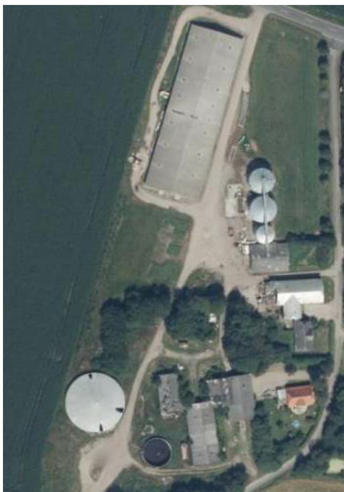
Figur 1. Oversigt over bygninger.
