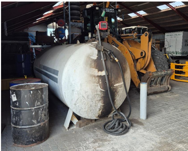
Figur 1. 5900 L olietank. Stillet til rådighed af OK i 2004. Sikret mod påkørsel. Tønder ved siden af er tomme.
