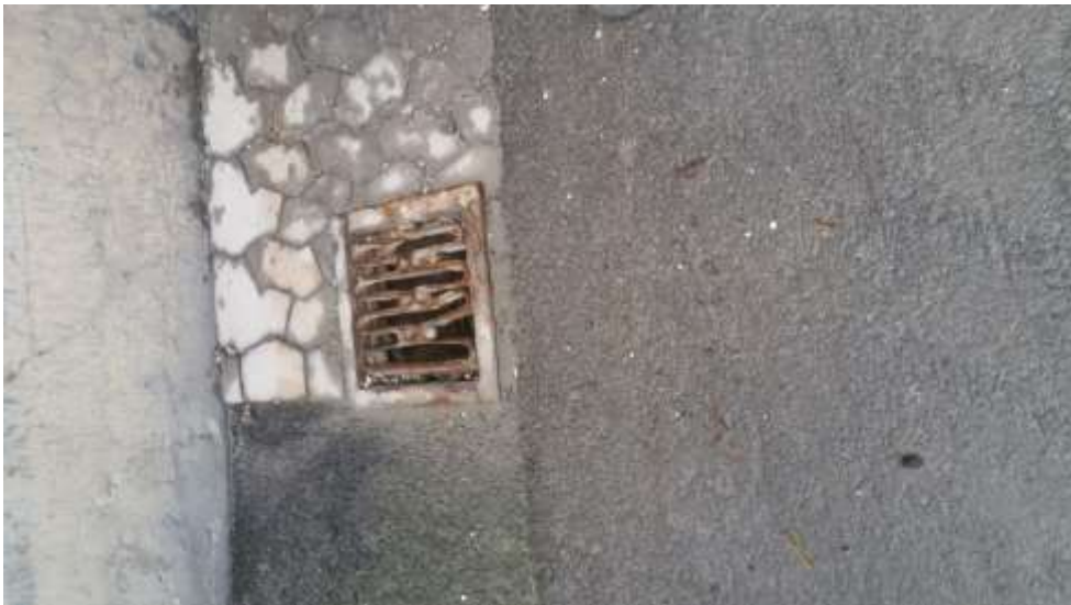
Nedløbsbrønd og sf-sten på arealet foran slaggehallen
