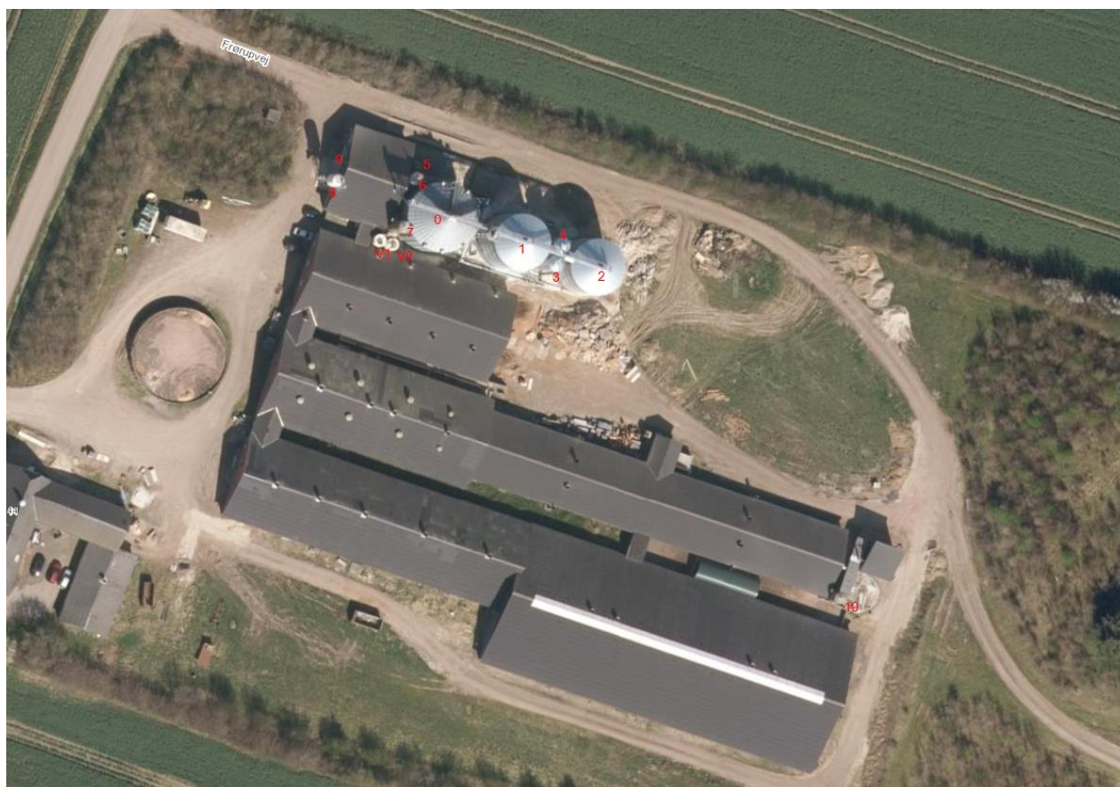
Figur 1. Oversigt over siloer på ejendommen
