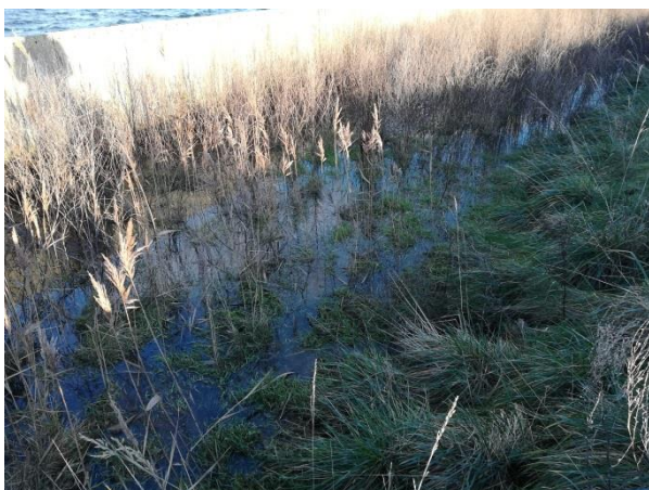
13. Vand og beplantning mellem dige og spuns
