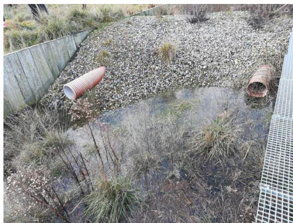
20. Rørgennemføringer i sydøstlige stenkiste
