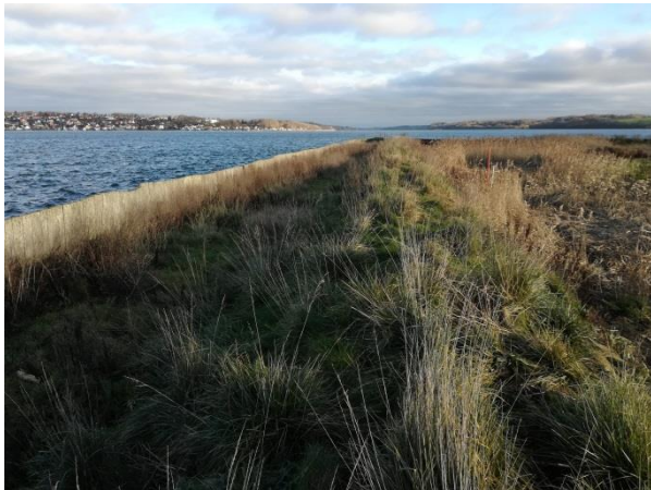
12. Dige, mellemrum og spuns på nordside
