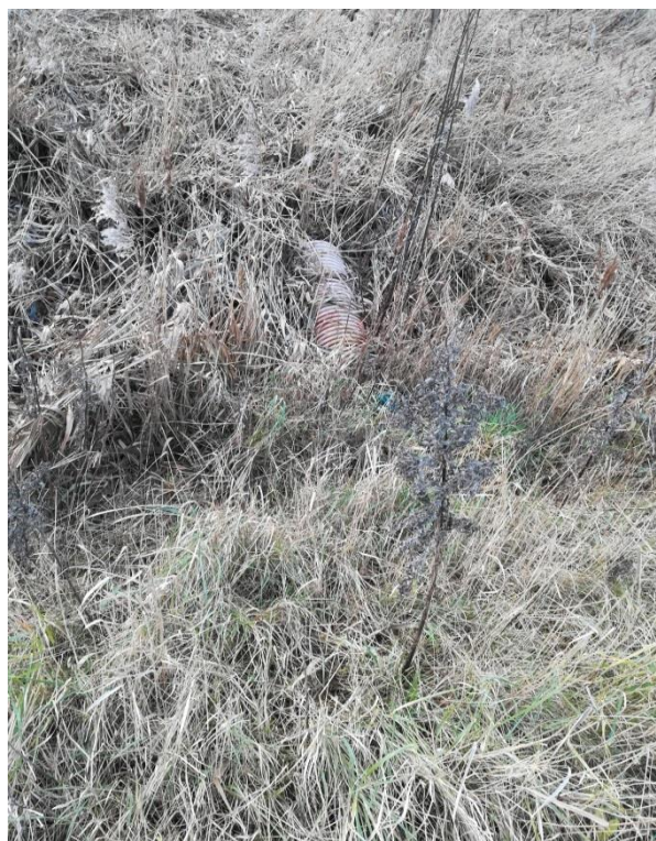
29. Rørgennemføring i vestligt dige, sydlig del
