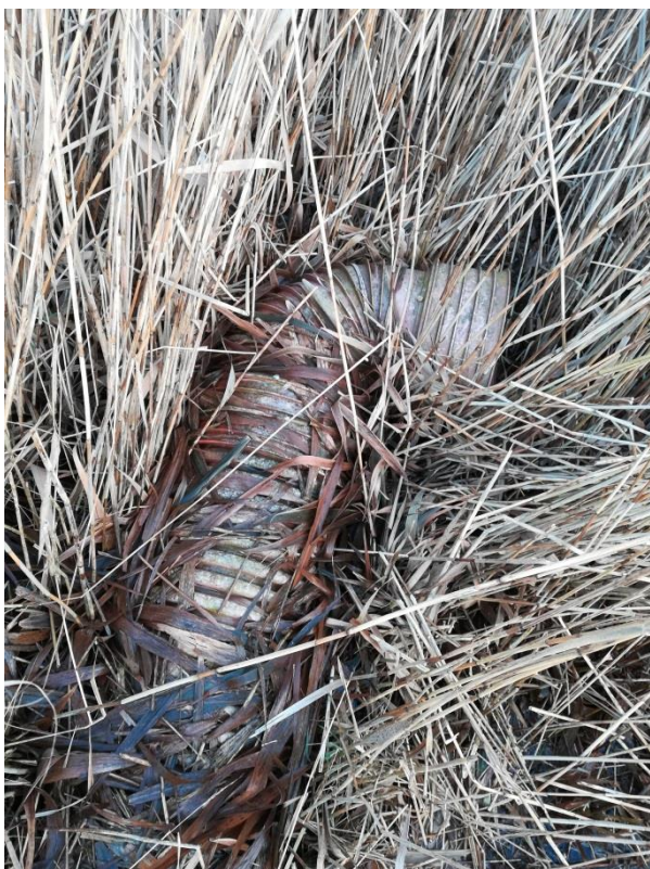
31. Rørgennemføring i vestligt dige, sydlig del
