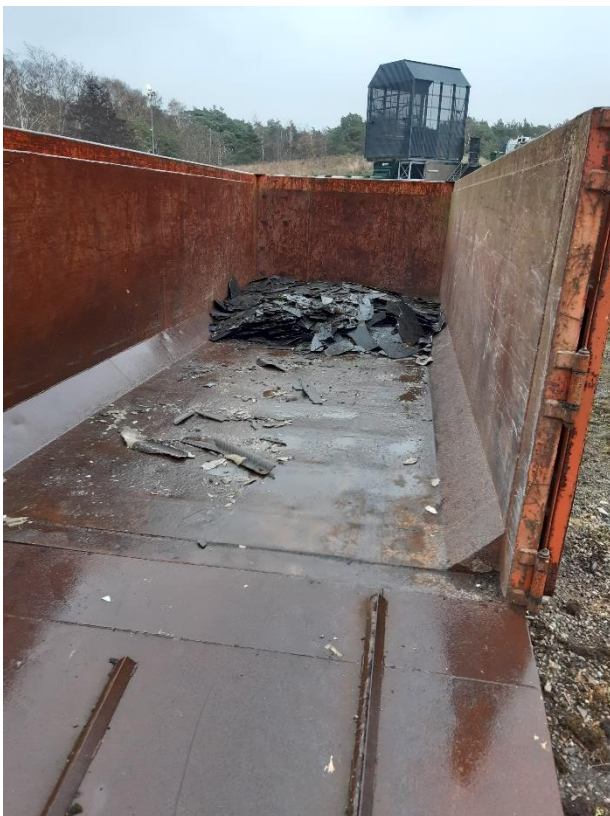
Figur 5: Container til asbestaffald stod åben og var ikke overdækket.
