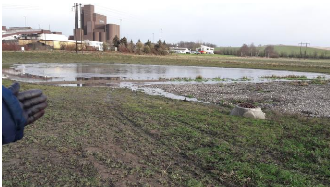
Fig. 5 Sandfilteret i sættebassinet er blevet udbedret/forstærket
