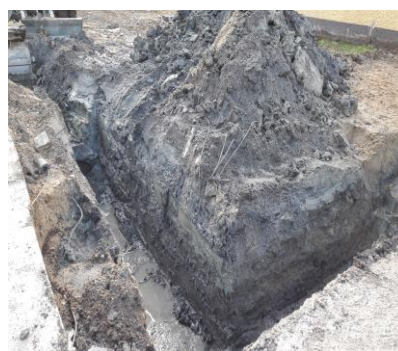
Fig. 2 Der blev gravet en rende på 1 m og 1,2 m.u.t. med prøvetagning i forskellige dybder
