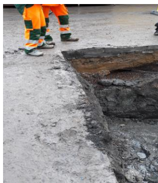
Fig. 1 Der ses et øvre fyldlag med bl.a. Leca. Der er et tykt betonlag over hele området
