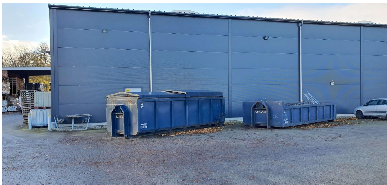
Containere til metalskrot. Containeren til venstre benyttes til skrot med oliefilm og er derfor over- dækket.
