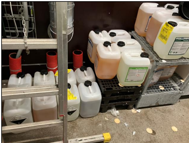
Opbevaring af vaskeprodukter i teknikrum med og uden spildebakke
