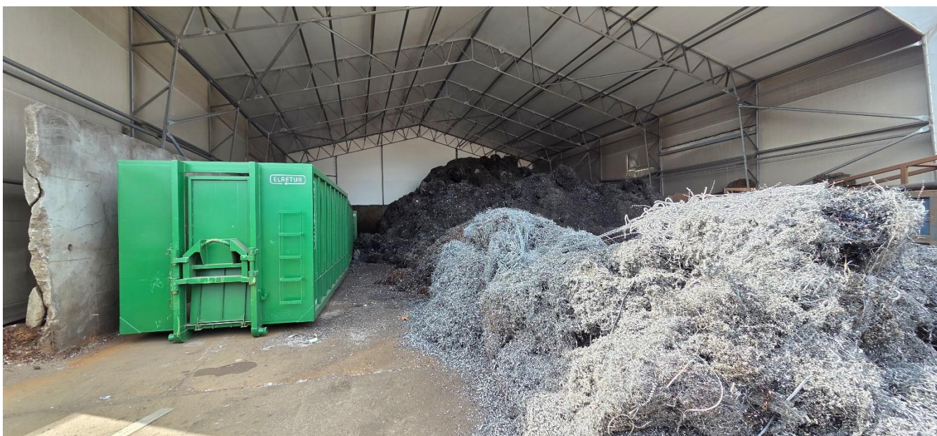
Telthallen med metalspåner. Det ses at spånerne opbevares inde i telthallen, hvor belægningen ser ud til at være i god stand. Spånerne der ses forrest var netop blevet læsset af og blev umiddelbart efter skubbet helt ind i telthallen. Der er ifm. tilsynet fremsendt billeder der viser telthallen når den er tømt og her ser belægningen ligeledes ud til at være i god og intakt stand.
