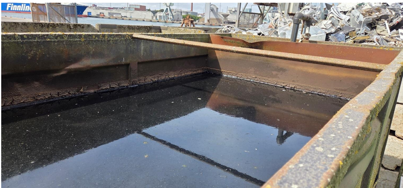
Bundfældningstankens vand er tydeligt dækket med et lag olie.
