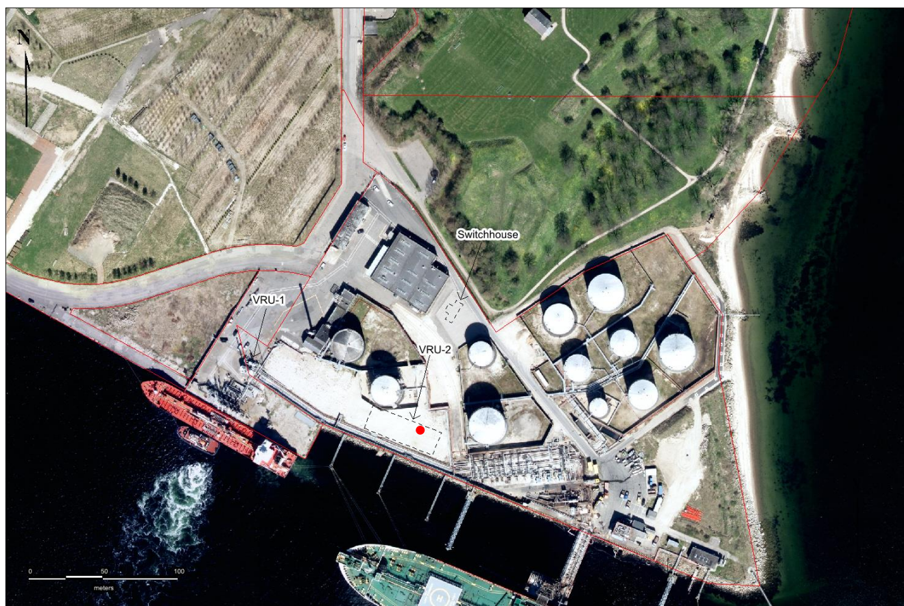
Figur 1 Placering af eksisterende (VRU-1) og kommende (VRU-2) dampgenvindingsanlæg. Den røde markering ved VRU-2 er den omtrentlige placering af afkastet.
