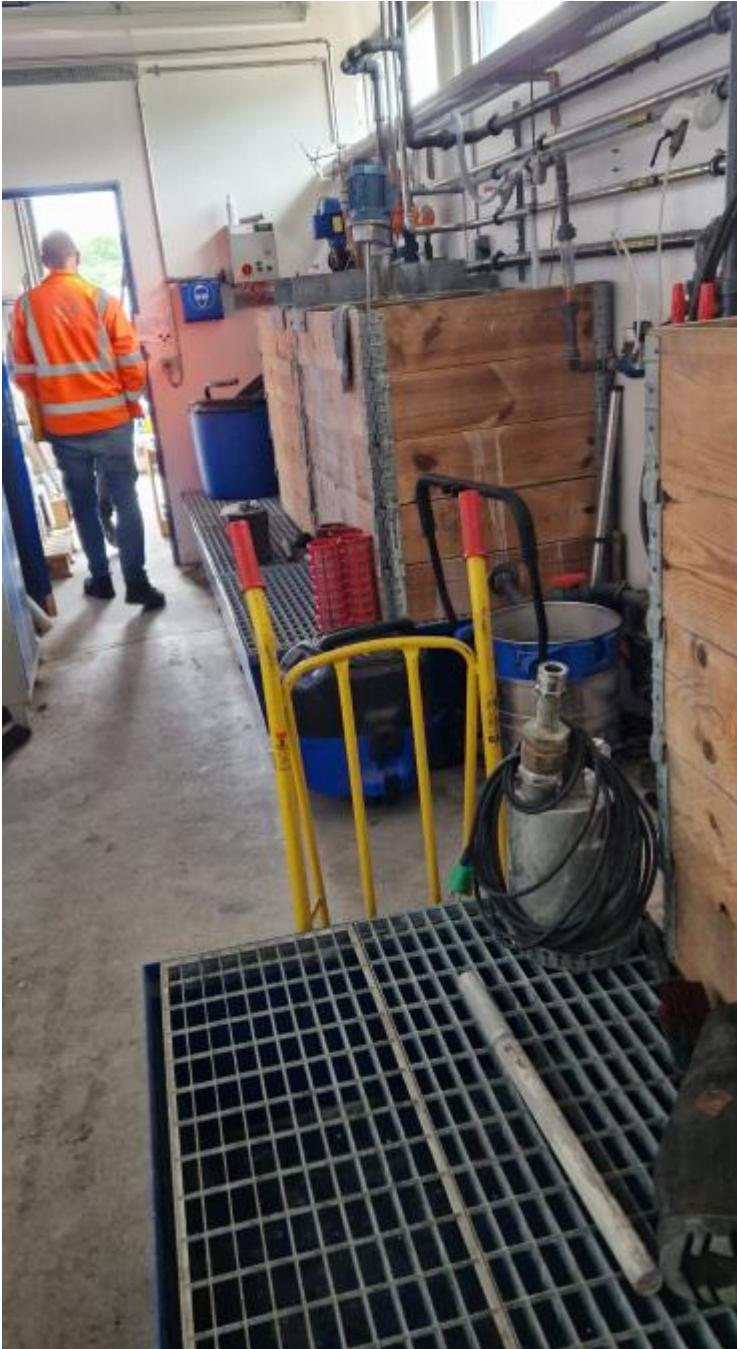
Vaskekemi til togvask opbevares i særskilt rum med spildsikring. Kemi ifm. graffiti fjernelse opbevares i hallen på spildbakker.
