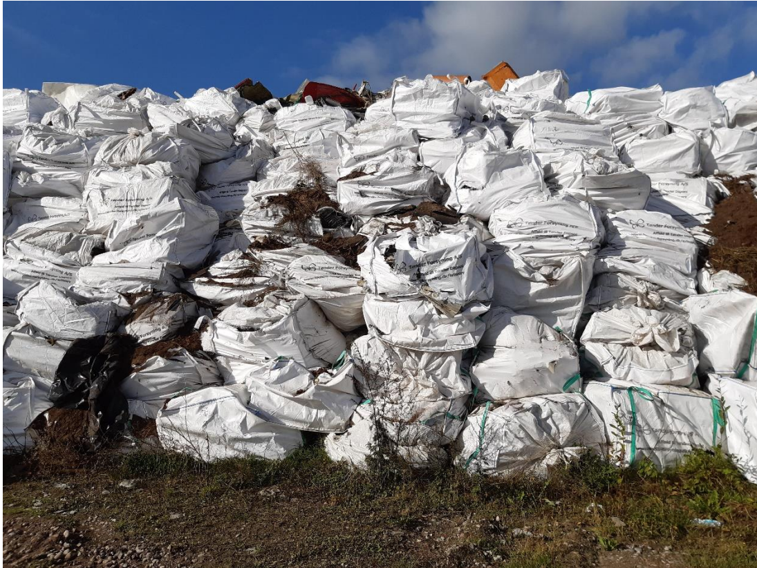
Billede 7 - Asbestcellen, eternitplader i Big Bags.
