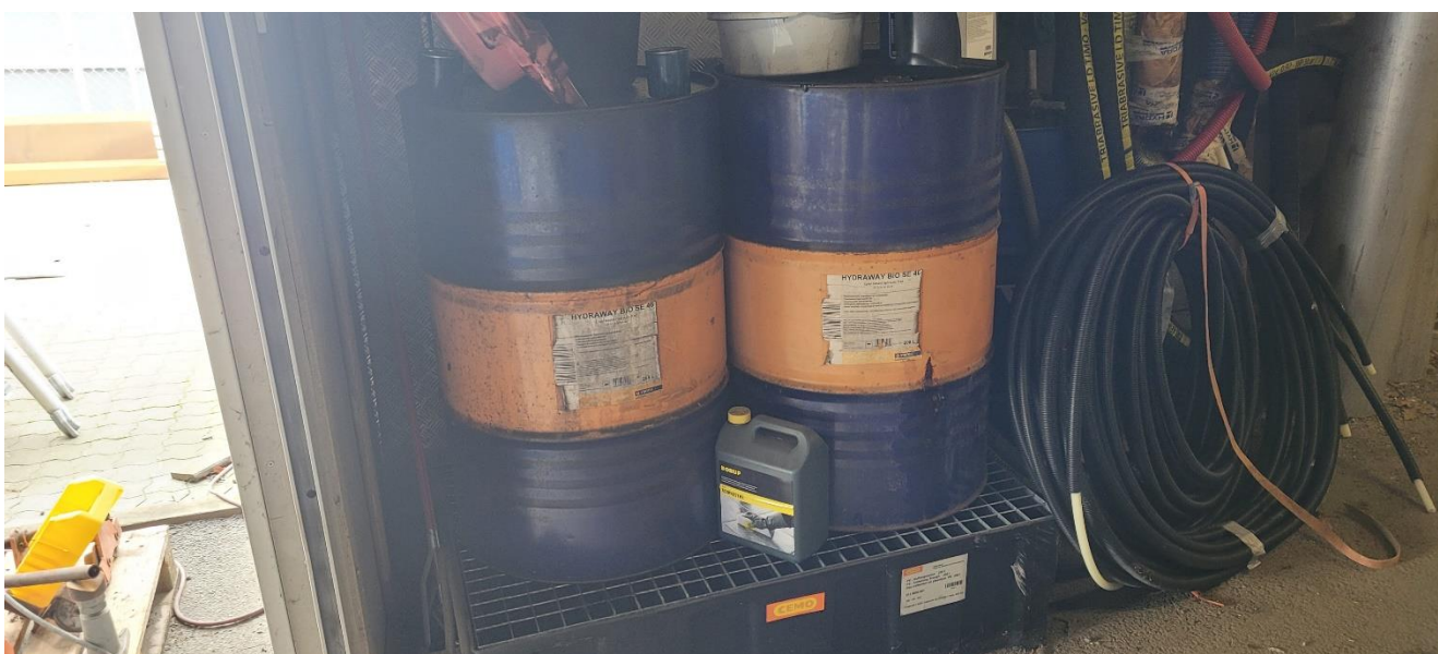
Spildolie opbevares i tromler på spildbakke.
