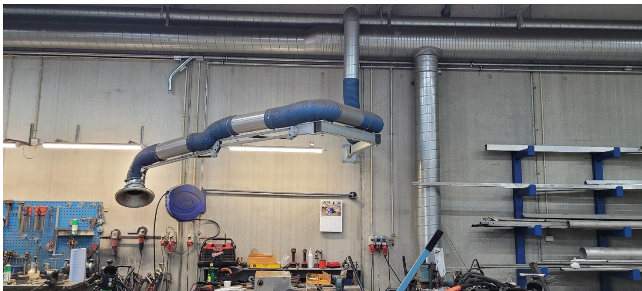
Udsugning til svejserøg m.m.
