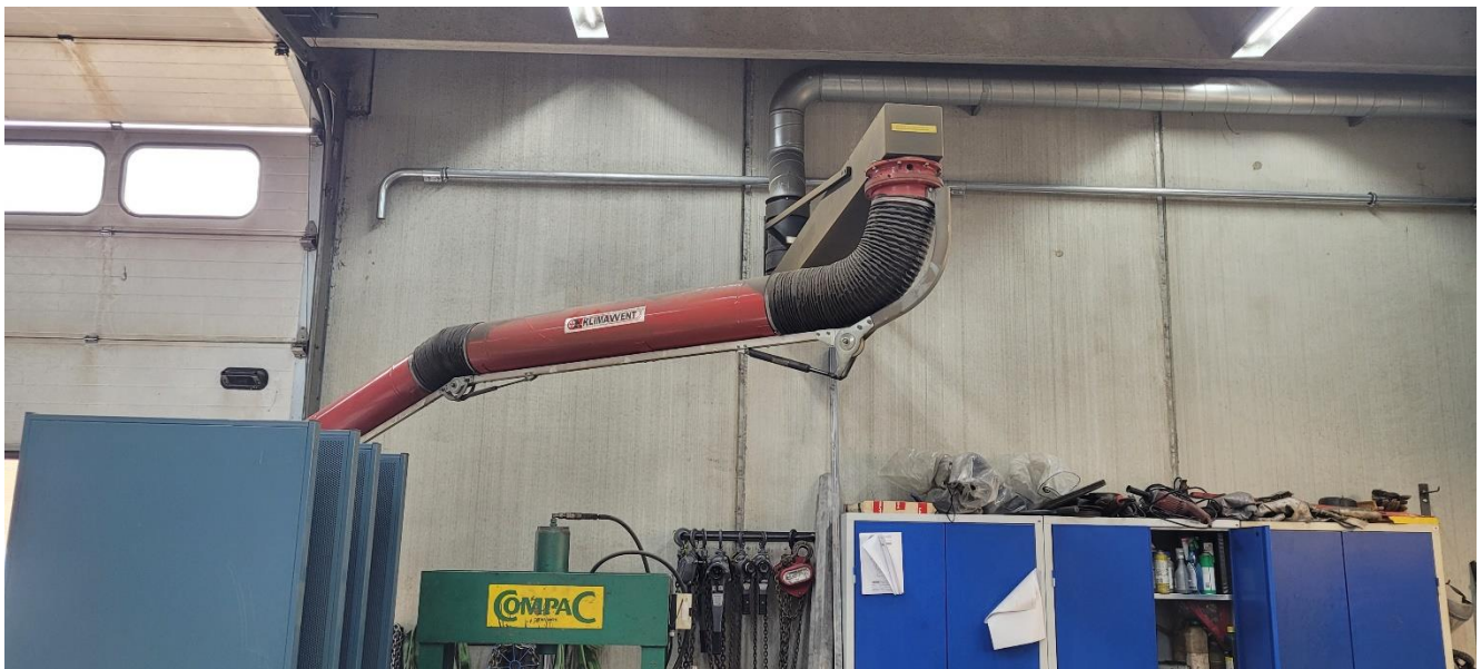
Udsugning til svejserøg m.m.
