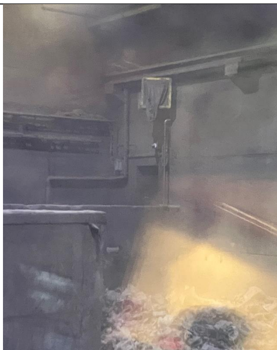
Foto 1: Vand/skumkanon i siloen. Den er tildækket med et klæde, for at beskytte om støv.
