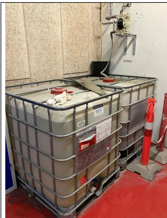
Foto 6: Skumbeholder ved skumstation 1
