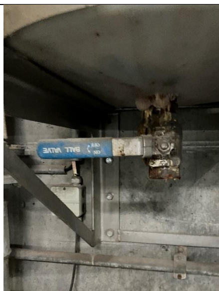
Foto 5: Studs under skumbeholder, anvendes ved prøvetagning/udskifning af skumprodukt.
