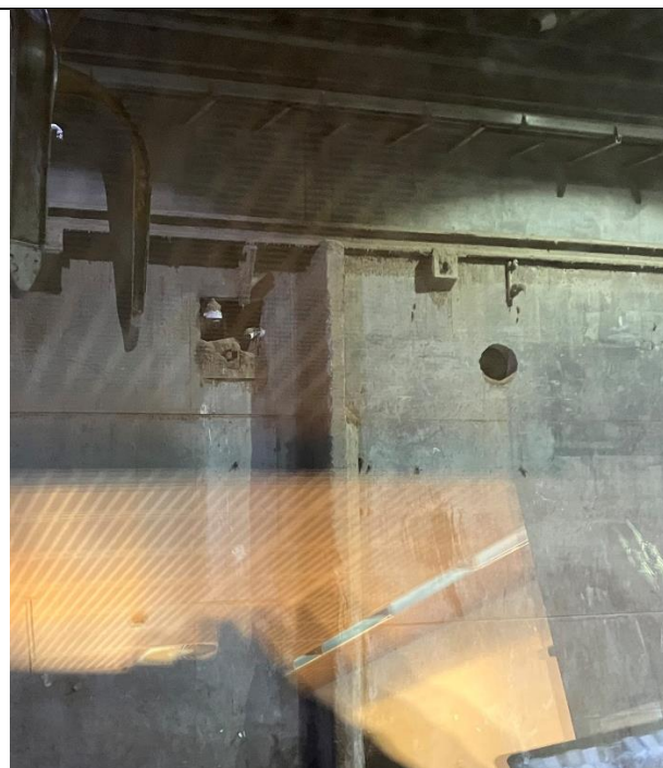
Foto 2: Vand/skumkanon i siloen uden tildækning.
