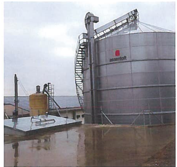
1314/9 á 1620 m 3 med vindeltrappe og 80 t transportanlæg. El-betjent låg til korngrav.
