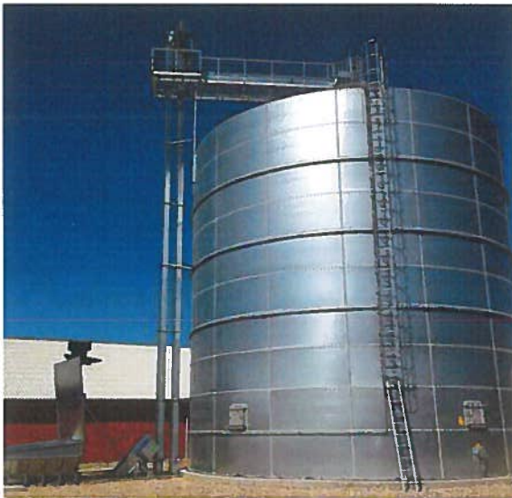
1238/10 á 1571 m 3 , helsvejt gangbro med 80 t transportanlæg og stål/galvaniseret påslag.
