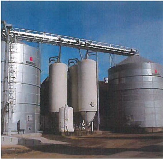
930/9 á 786 m 3 , 40 t transport med grav og helsvejt gangbro på 24 m.
